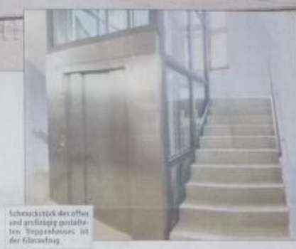
Schneckenstück des offen und großzügig gestalteten Treppenausses ist der Blickfang.
